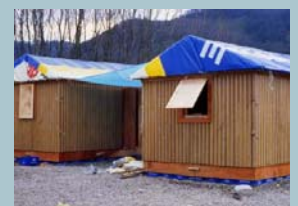
Shigeru Ban Paper Log Houses ; tubes en carton, caisses d'Evian, contreplaqué, poutre de plancher, toile de tente, 2000
